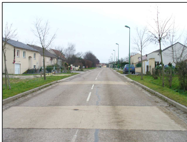
L'entrée de village de Gellenoncourt.
